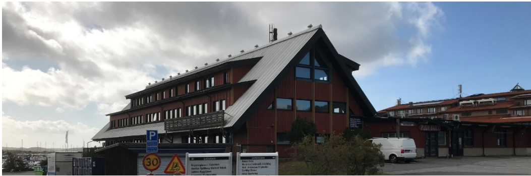
Befintlig verksamhetsbyggnad inom fastigheten.
